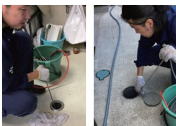
配水管高圧洗浄の様子 (左：屋内、右：屋外)
